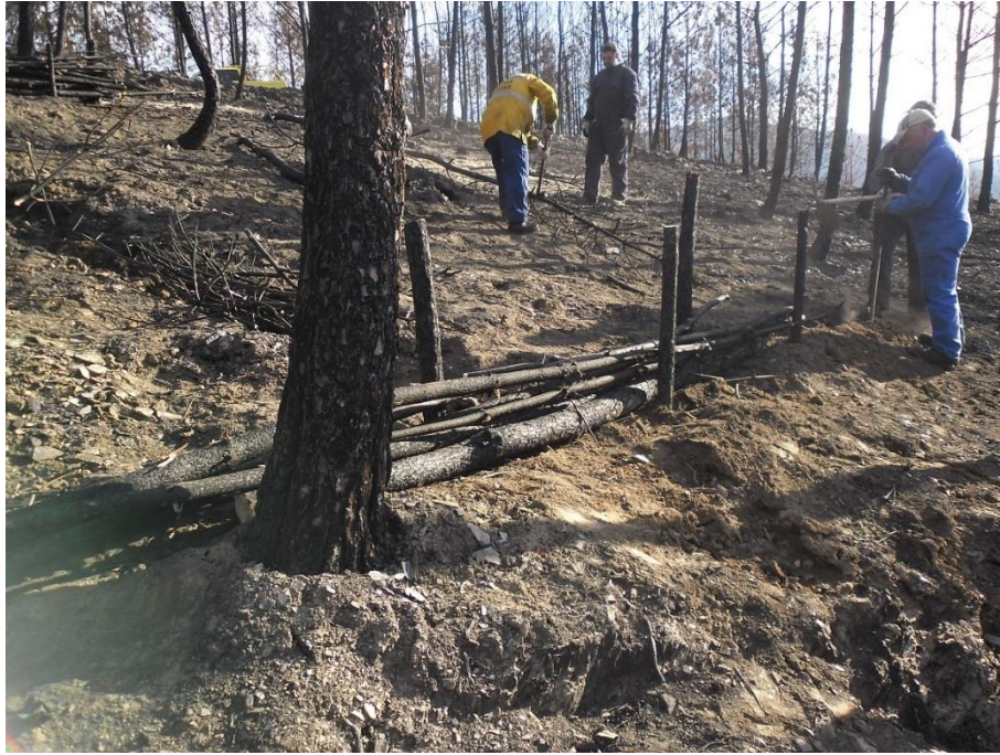
Figura 50- Montagem de “barreiras de troncos”, em Arganil (Fonte: https://www.noticiasdecoimbra.pt/ )
