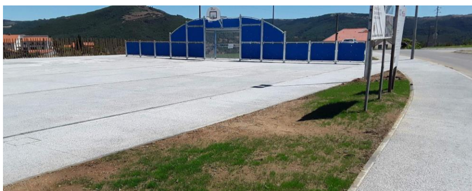
Figura 9- Exemplo de jardim regado por pulverização
