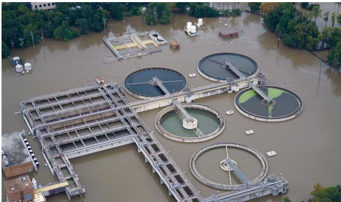
Figura 34- Inundação de uma ETAR em Houston, Texas, durante o furacão Harvey, em 2017 (Fonte: Water Finance & Management)
