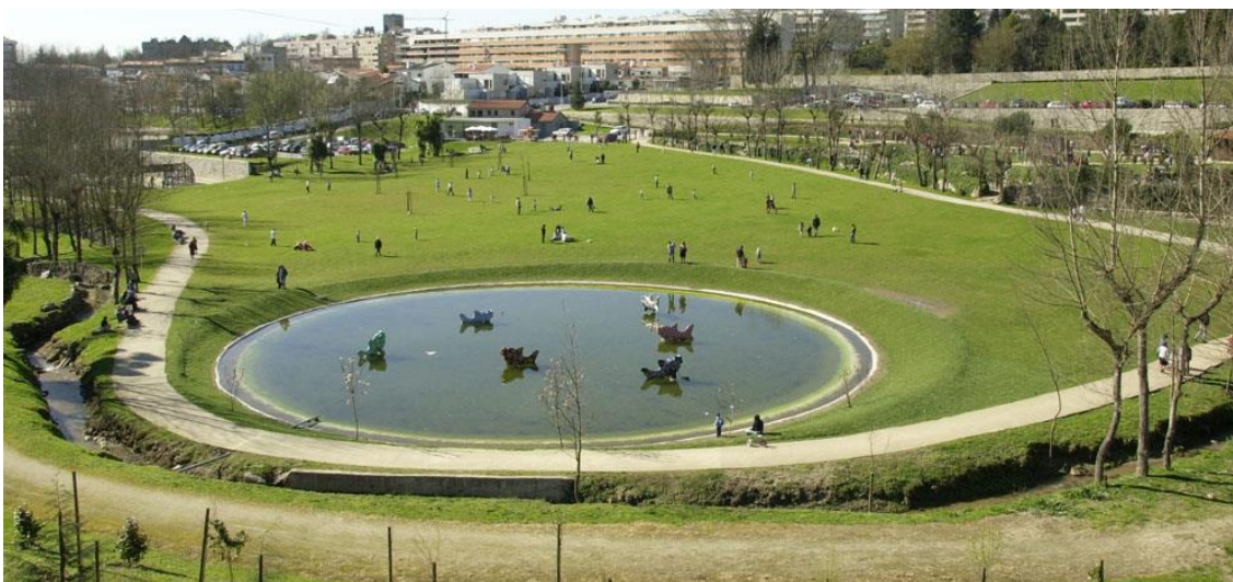
Figura 13- Bacia de retenção em jardim público
