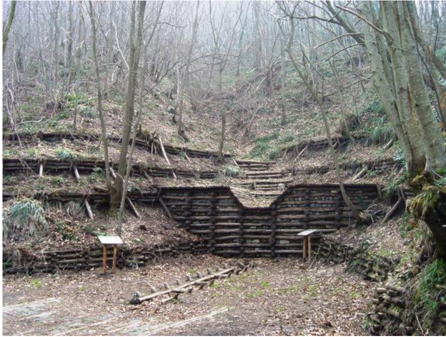
Figura 52- Barragem de correção torrencial (Fonte: Flickr )
