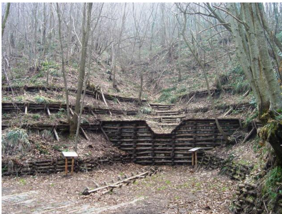
Figura 52- Barragem de correção torrencial (Fonte: Flickr )
