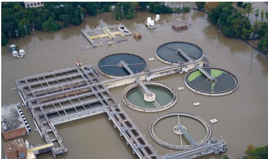
Figura 34- Inundação de uma ETAR em Houston, Texas, durante o furacão Harvey, em 2017 (Fonte: Water Finance & Management)
