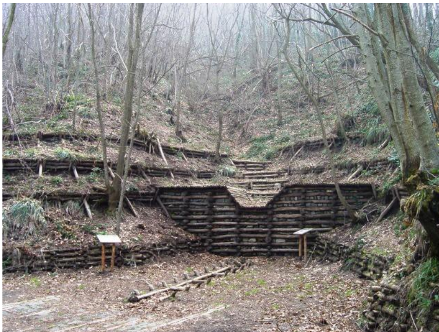
Figura 52- Barragem de correção torrencial (Fonte: Flickr )
