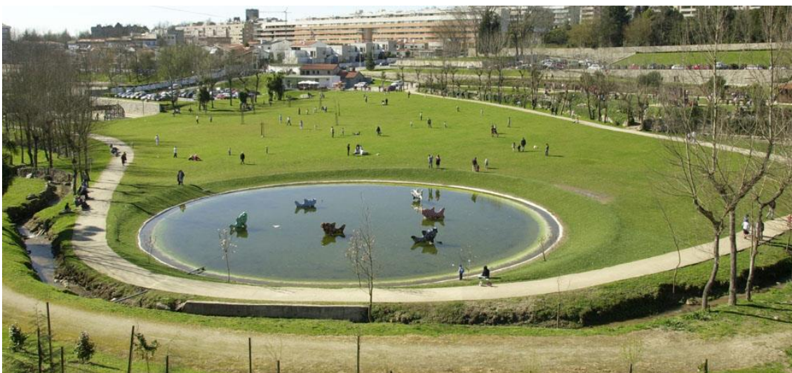
Figura 13- Bacia de retenção em jardim público
