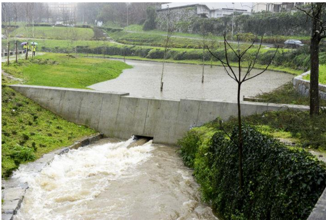
Figura 32- Exemplo de uma bacia de retenção em Guimarães (Fonte: Guimarães Mais Verde )
