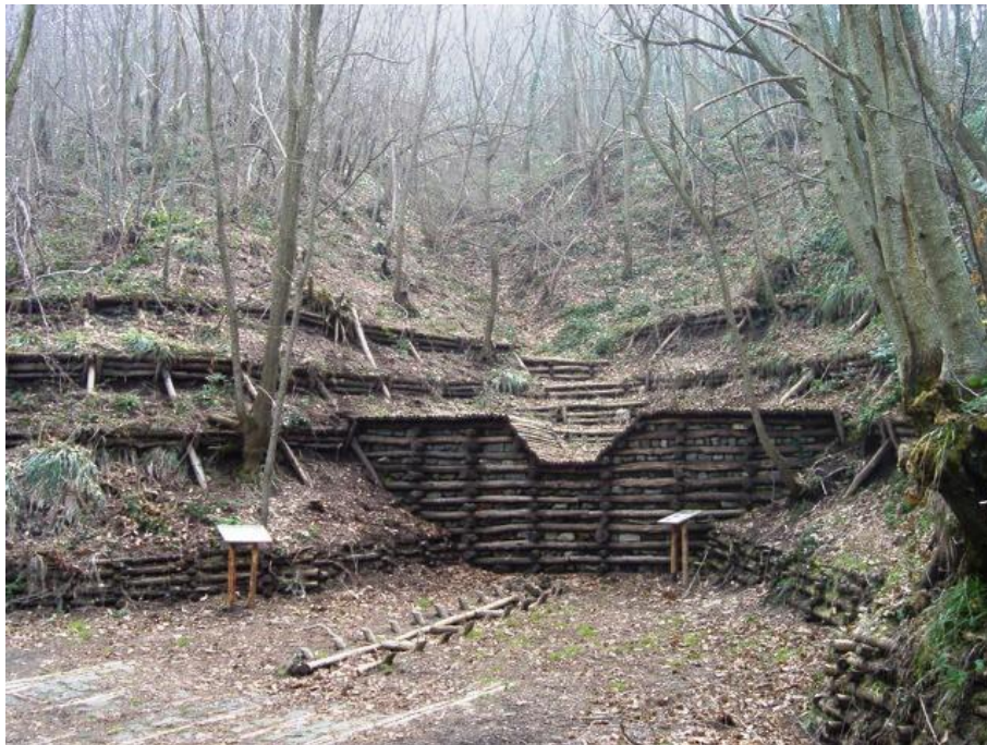
Figura 52- Barragem de correção torrencial (Fonte: Flickr )
