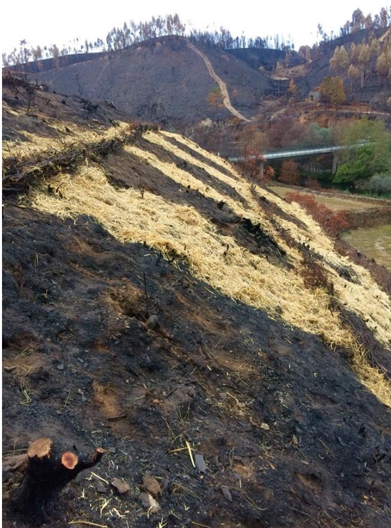
Figura 49- Aplicação de “mulch” em palha, em Penacova (Fonte: Medronhalva )
