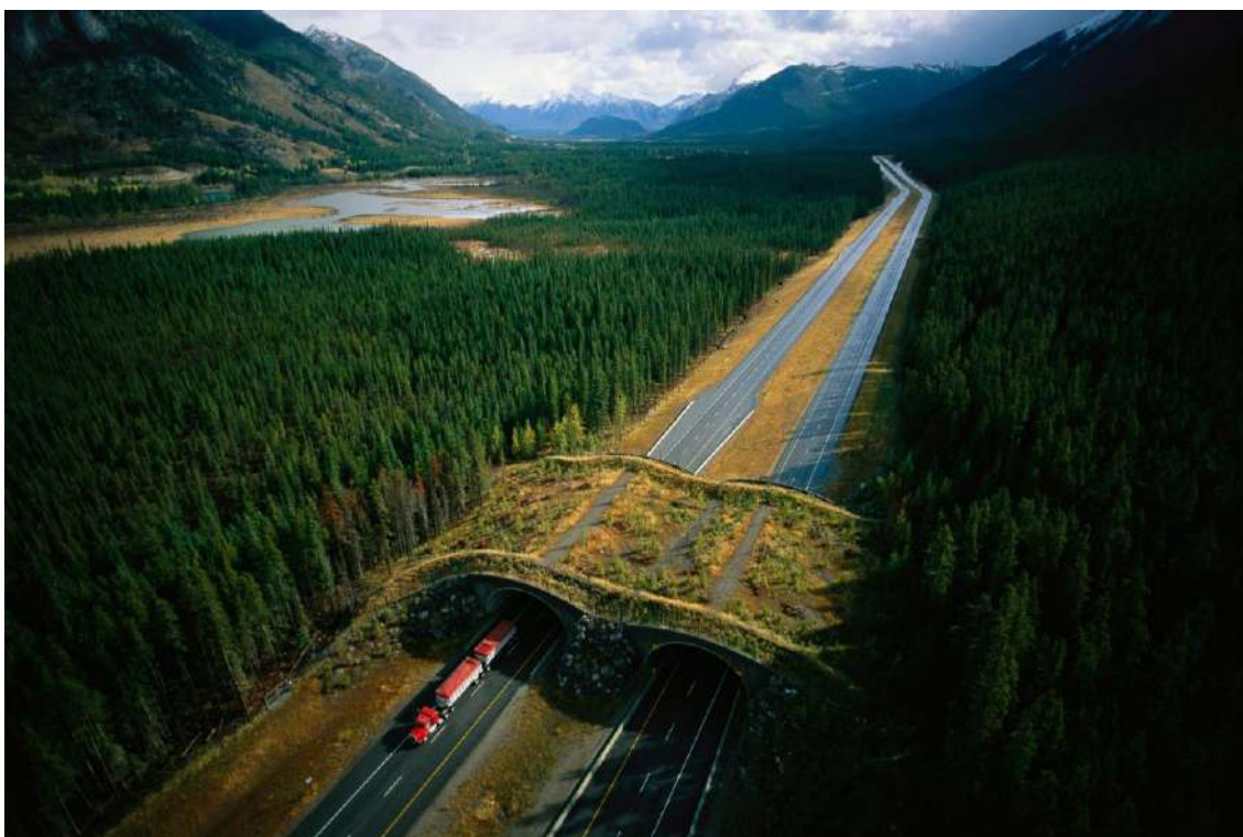
Figura 123 – Um “eco-viaduto” como nova solução de corredor verde para a passagem da vida selvagem
